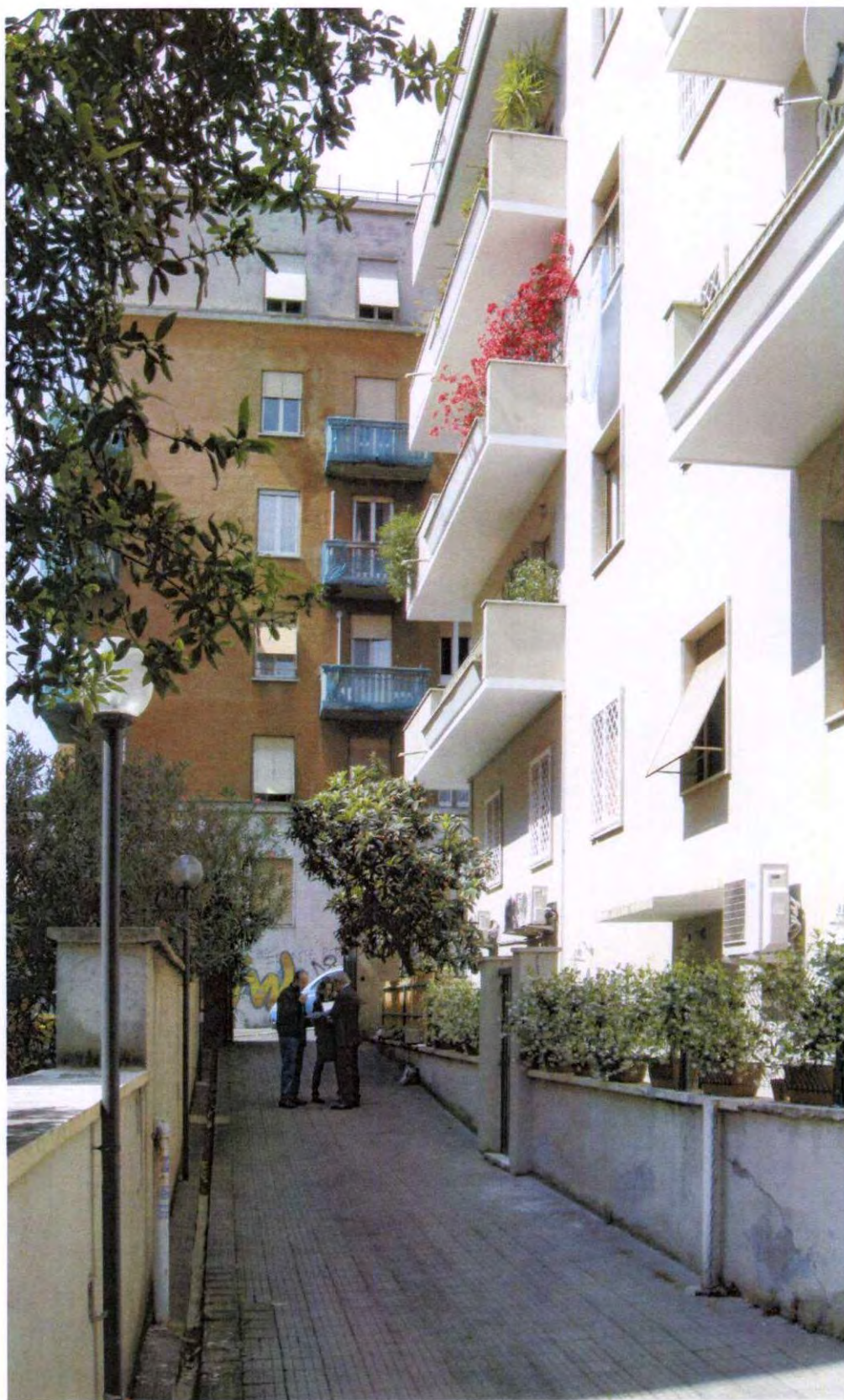
Vista della rampa verso Via Pusiano
