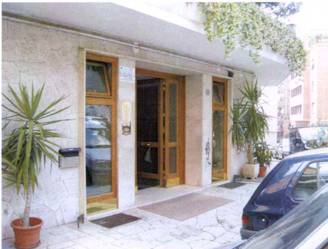
Particolare dell'ingresso alla palazzina
