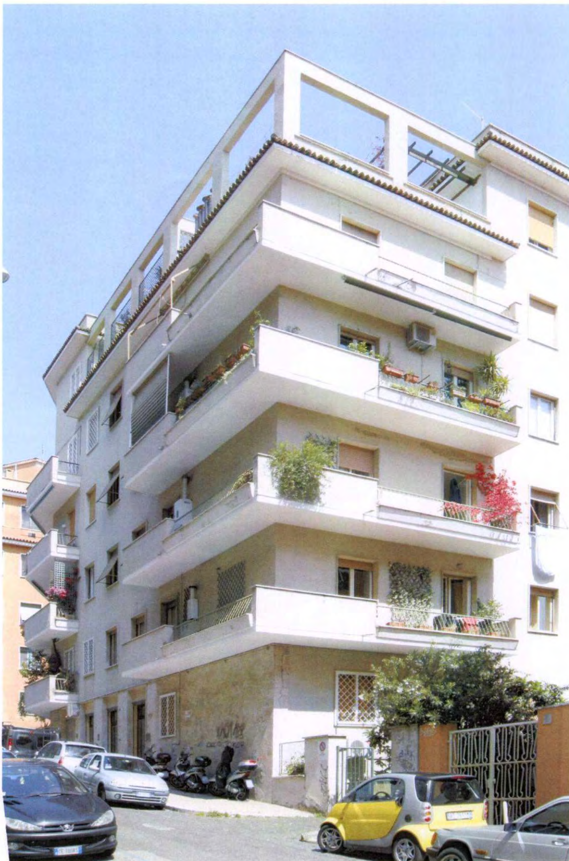
Vista dell'ingresso ai box condominiali su Via Pusiano
