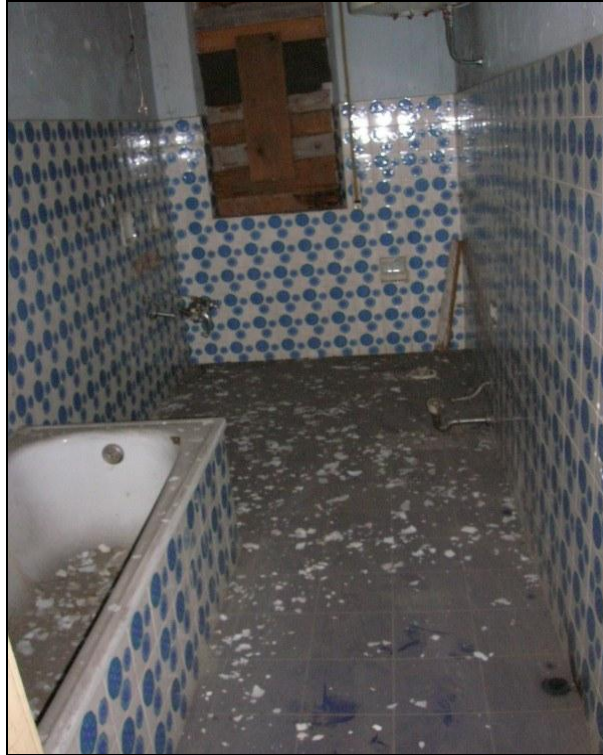
Foto 3 - stato manutentivo pavimentazione e rivestimento del bagno.
