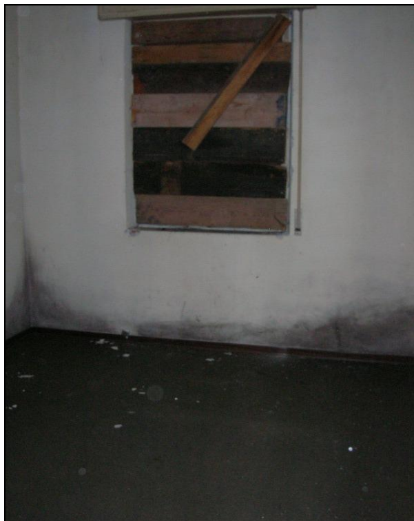
Foto 2 - stato manutentivo pavimentazione della camera.
