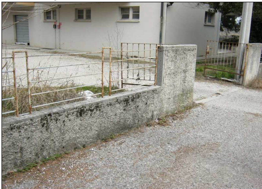
Foto 3 – Particolare fotografico relativo al muro perimetrale che delimita il giardino di pertinenza del fabbricato.
