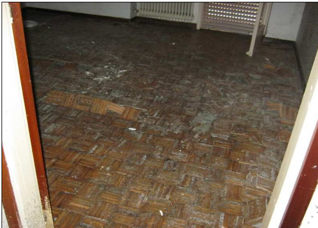
Foto 3 - stato manutentivo pavimentazione delle camere.
