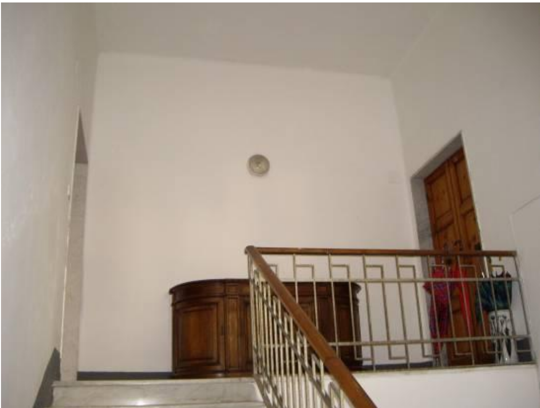
Vano scala accesso al primo piano
