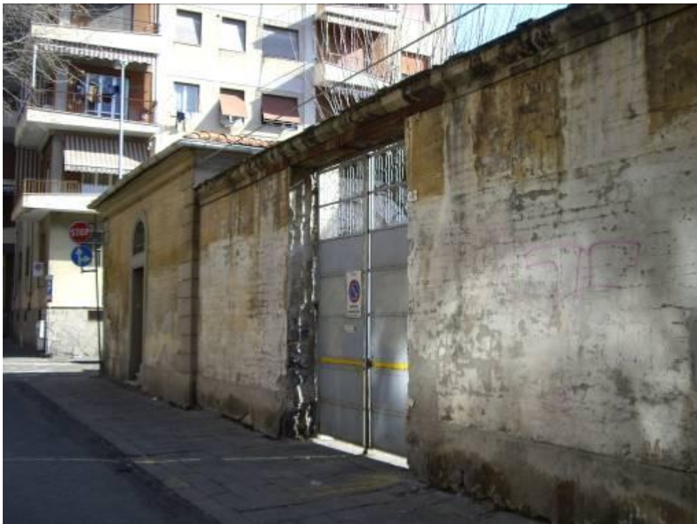
Accesso carraio su via Garibaldi
