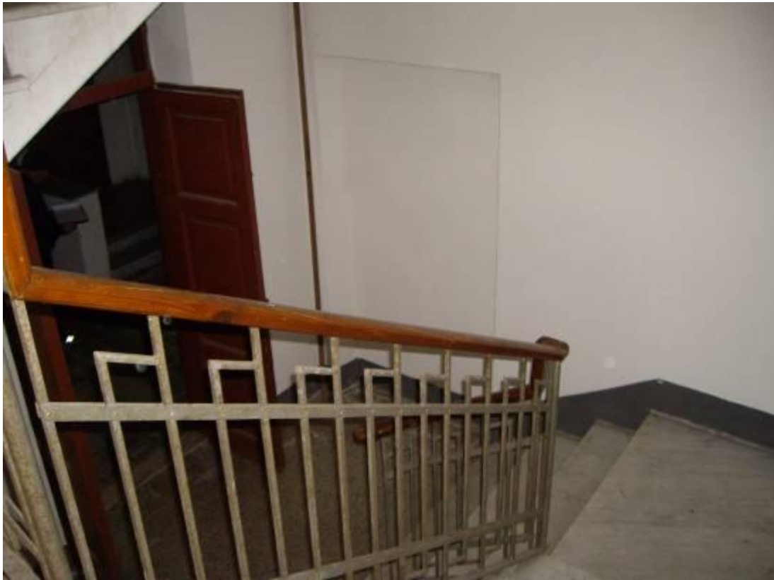
Vano scala accesso dall'androne
